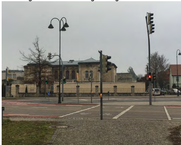
Abbildung 2: JVA mit Schwurgerichtsgebäude
