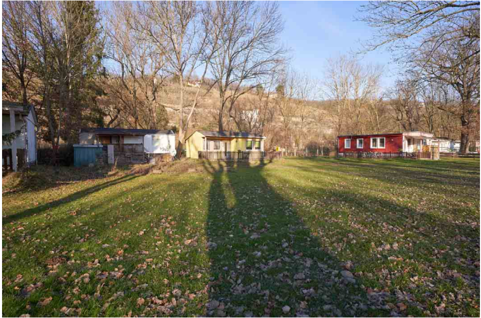
| Abb. 56 Haus 2-2 mit Nebengebäude (links) Haus 3 (rechts)
