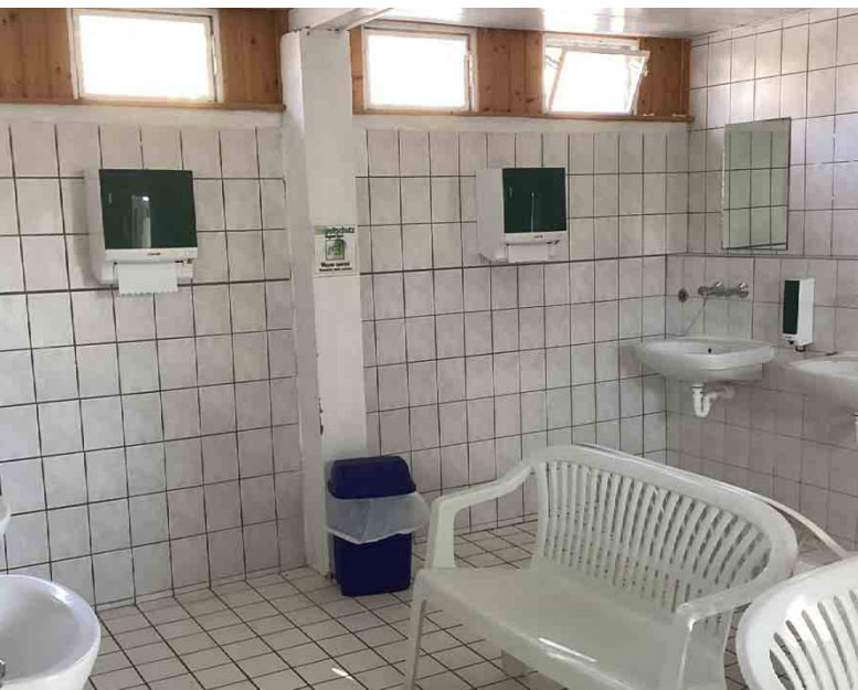
| Abb. 27 Innenraum Sanitär- und Lagergebäude aus den 60ern
