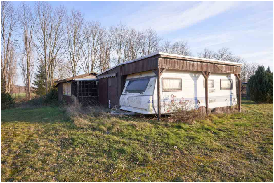
| Abb. 89 Bauliche Einhausung Campingmobil
