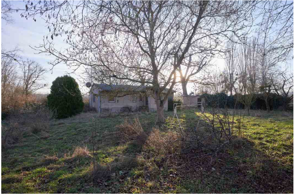
| Abb. 74 ehem. Bademeisterhaus mit Garage im Süden des Grundstücks
