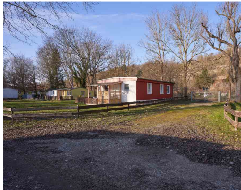
| Abb. 55 Haus 3 (vorne) und Haus 2-2 mit Nebengebäude (hinten)
