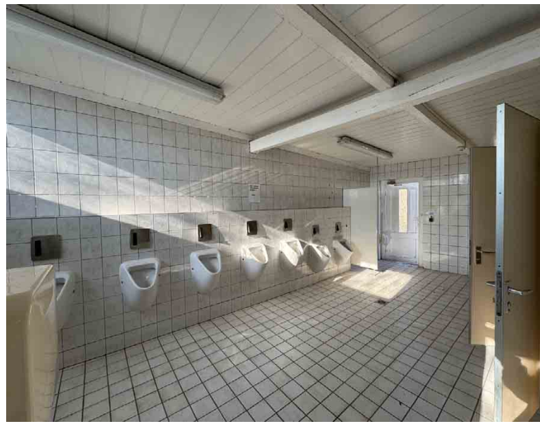
| Abb. 31 Urinale Sanitär- und Lagergebäude aus den 60ern
