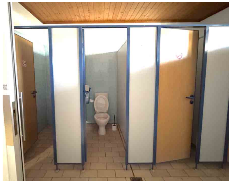
| Abb. 40 WC-Kabinen neues Sanitär- und Lagergebäude (nicht saniert)
