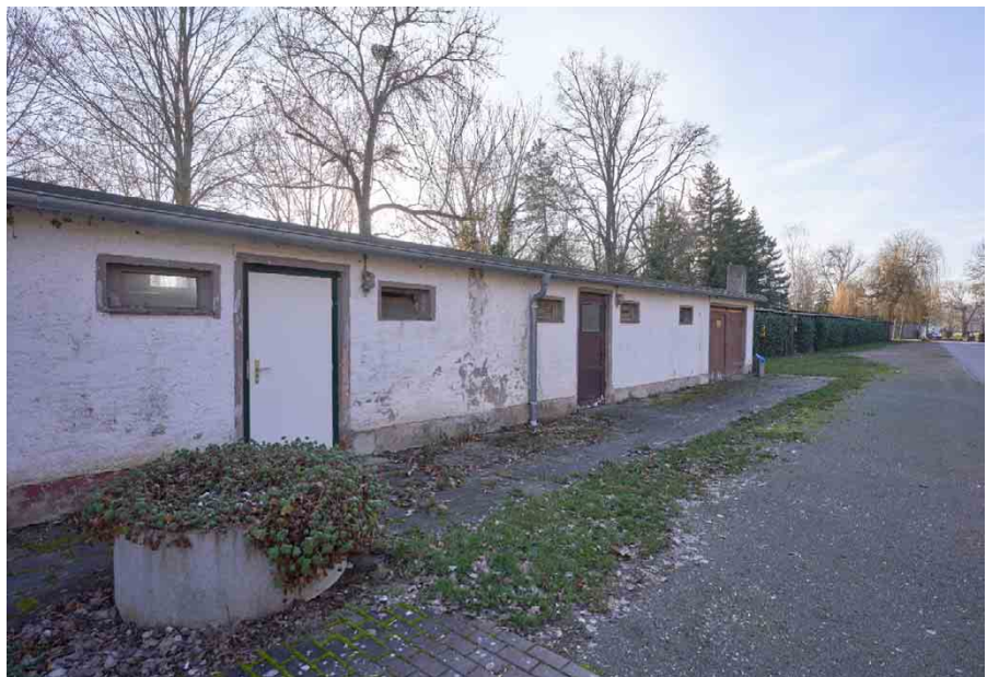
| Abb. 32 Sanitär- und Lagergebäude aus den 60ern
