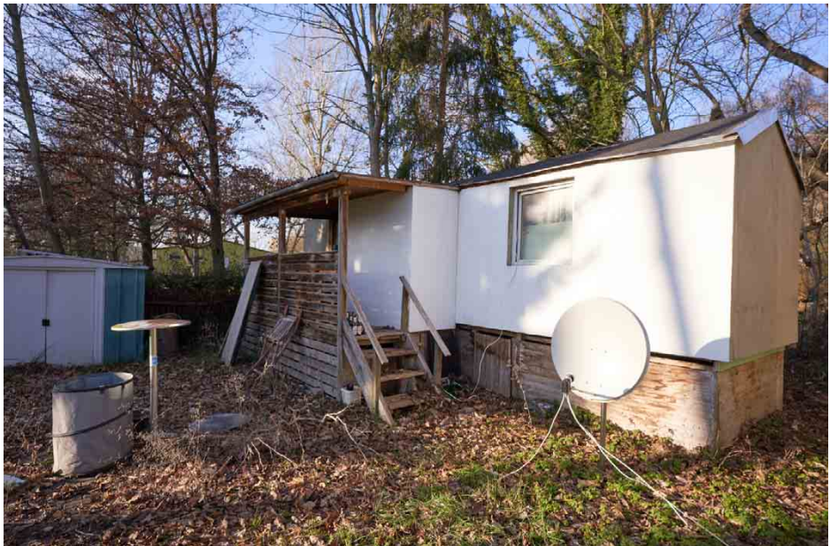
| Abb. 59 Nebengebäude Haus 2-2
