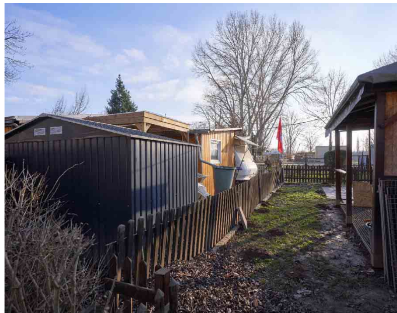
| Abb. 94 Bauliche Anlagen einer DauercamperIn: Einfriedung, Überdachung, Schuppen
