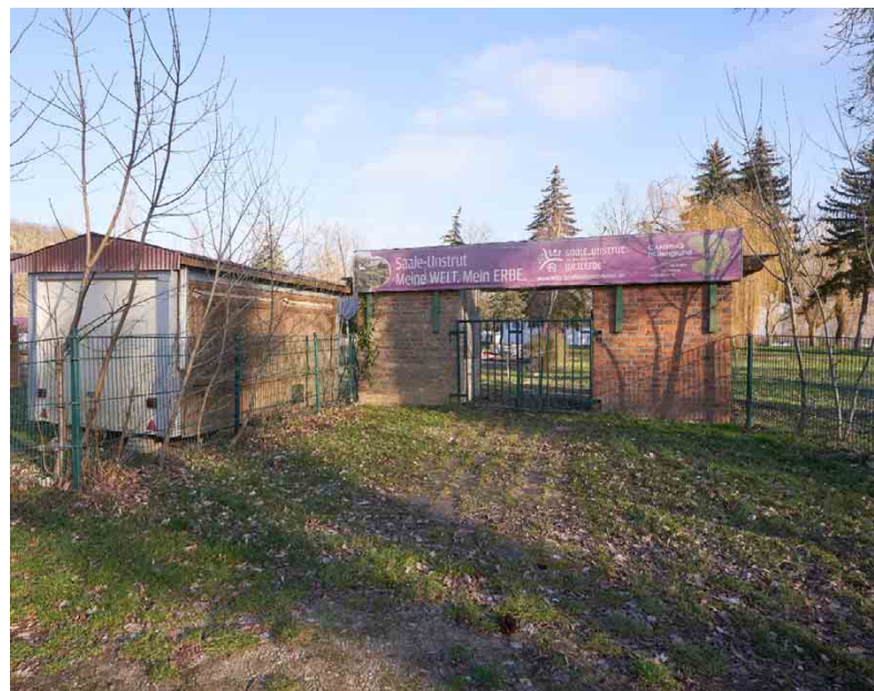
| Abb. 10 Ehemaliger Eingang Badesees
