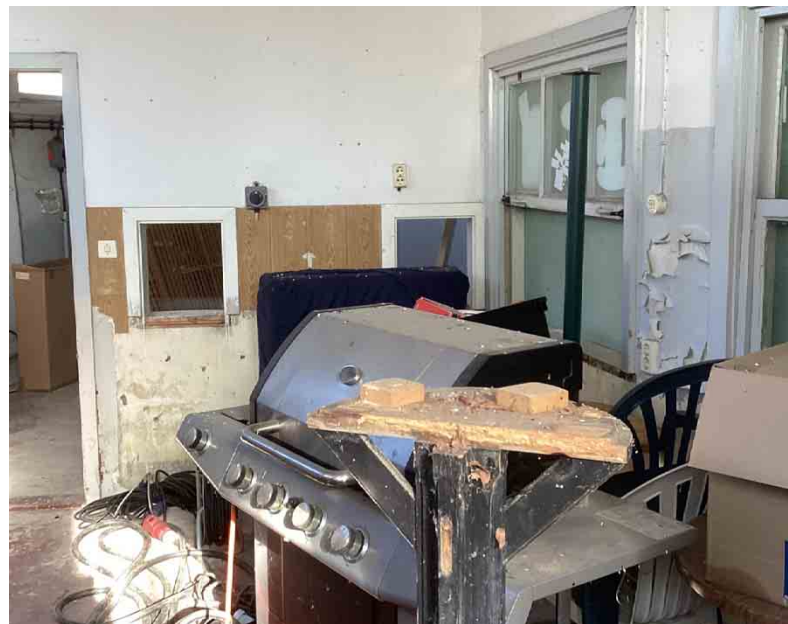
| Abb. 67 Zustand Innenräume Gemeinschaftspavillon (Lagerfläche)
