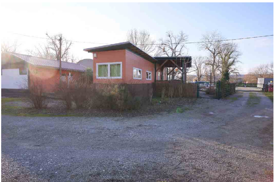
| Abb. 122 Wohnhaus Kanuverleih "Saale-Unstrut Tours"
