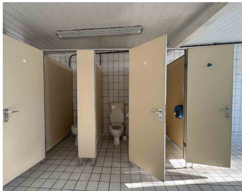
| Abb. 28 WC-Kabinen Sanitär- und Lagergebäude aus den 60ern
