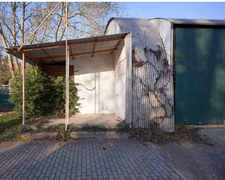
| Abb. 21 Überdachung Rundbogenhalle
