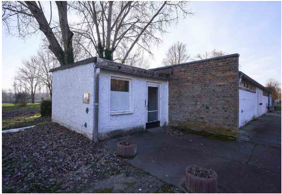
| Abb. 26 Sanitär- und Lagergebäude aus den 60ern
