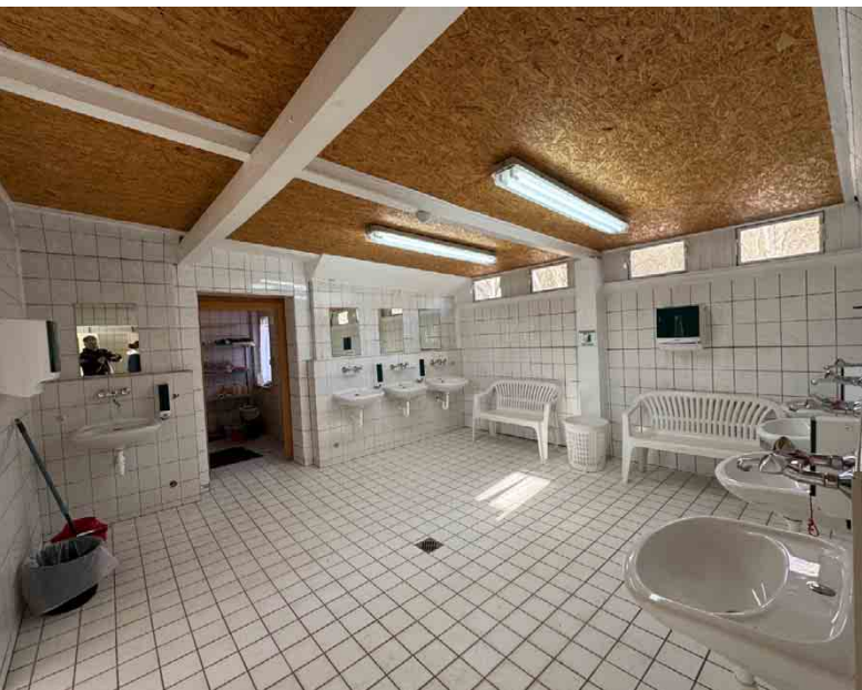
| Abb. 30 Innenraum Sanitär- und Lagergebäude aus den 60ern
