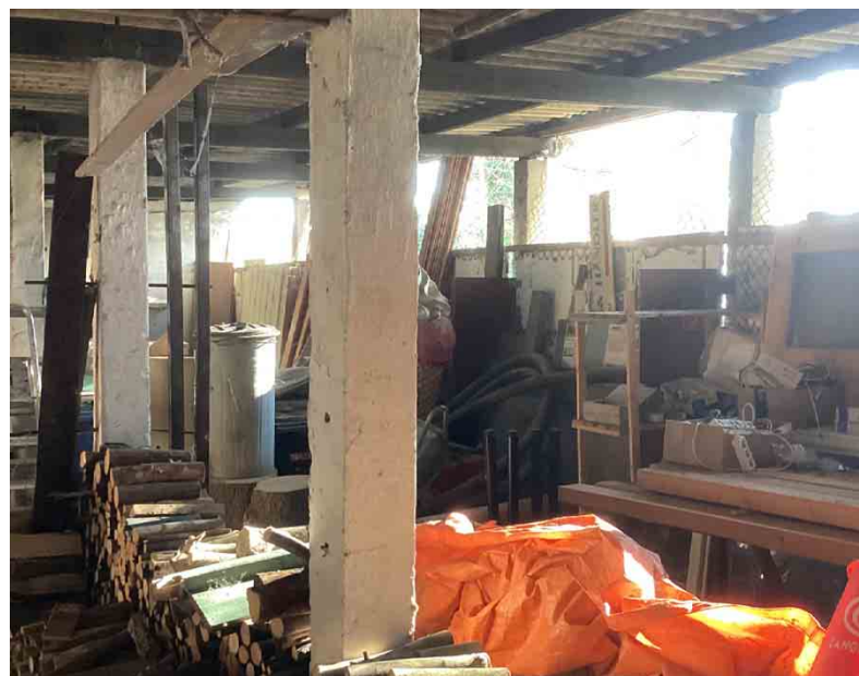
| Abb. 52 Innenraum Werkstatt- und Lagergebäude
