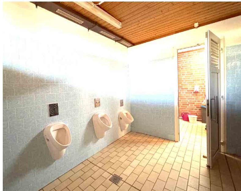
| Abb. 37 Urinale neues Sanitär- und Lagergebäude (nicht saniert)
