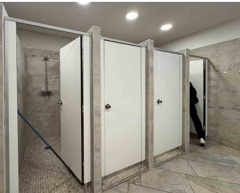
| Abb. 39 Wasch- und Duschbereich neues Sanitär- und Lagergebäude (saniert)
