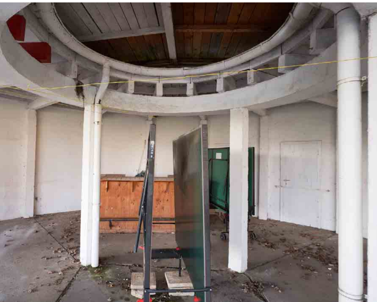
| Abb. 63 Tragstruktur Betonring und ringförmig ausgerichtete Dachträger
