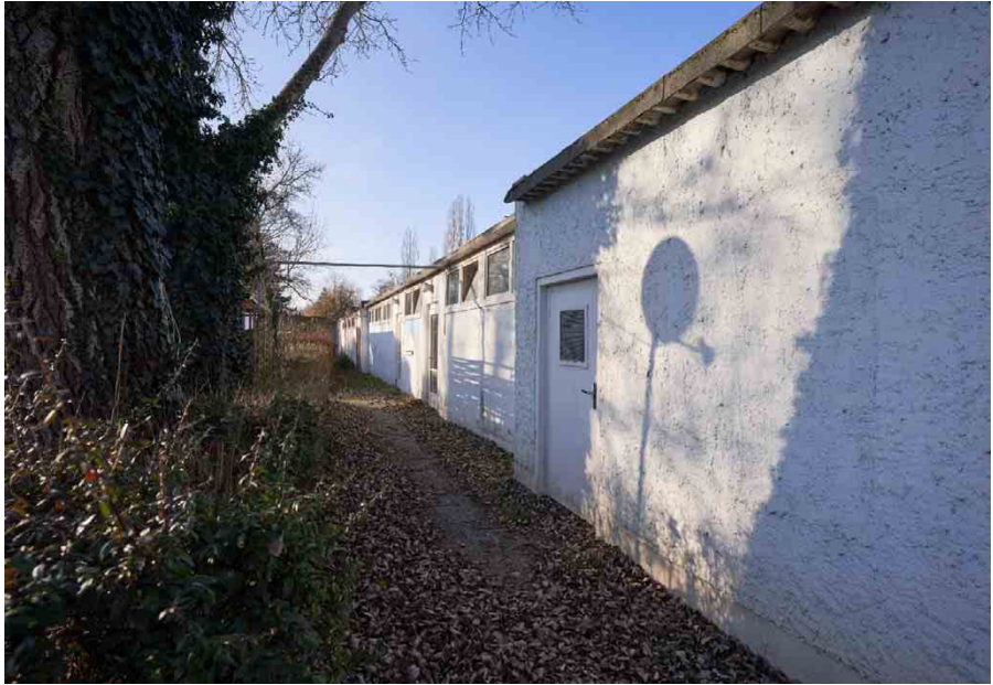
| Abb. 47 Rückseite Sanitär- und Lagergebäude aus den 60ern
