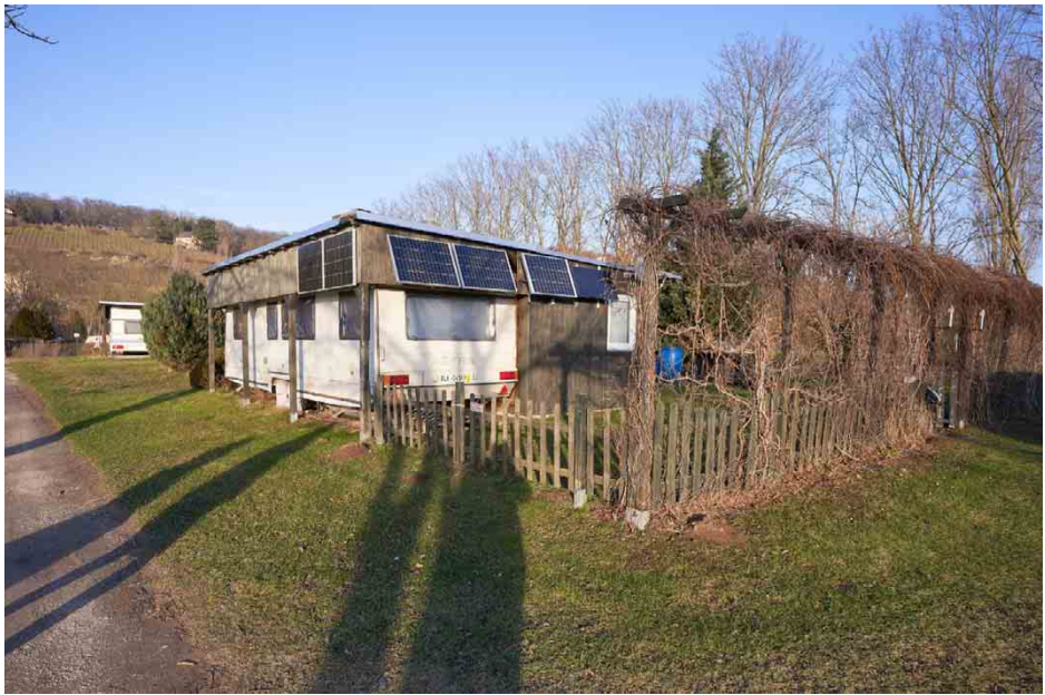
| Abb. 92 Bauliche Einhausung Campingmobil mit Photovoltaikanlage und Einzäunung
