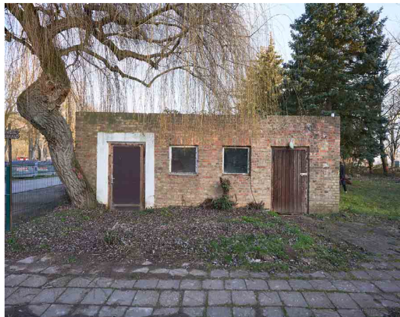
| Abb. 76 Zugang Elektrounterverteilung
