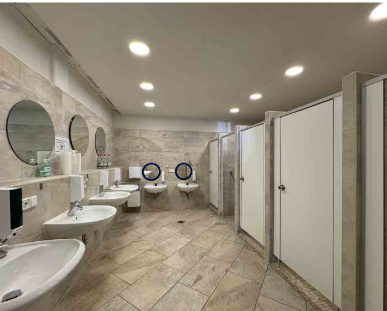
| Abb. 36 Wasch- und Duschbereich neues Sanitär- und Lagergebäude (saniert)
