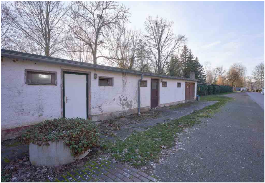
| Abb. 44 Sanitär- und Lagergebäude aus den 60ern
