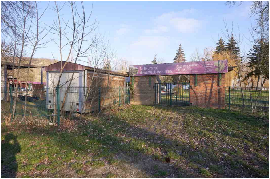
| Abb. 71 ehem. Zugang Badeseesee (rechts), Anhänger mit Nutzaufbau (links)
