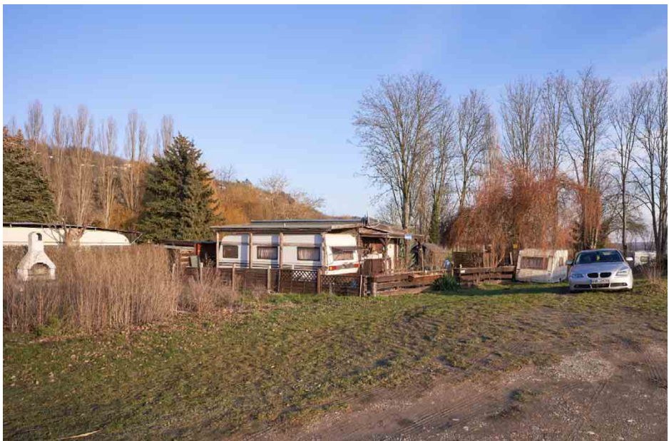
| Abb. 95 Eingezäunte Dauercamping-Anlage mit baulicher Einhausung Campingmobil
