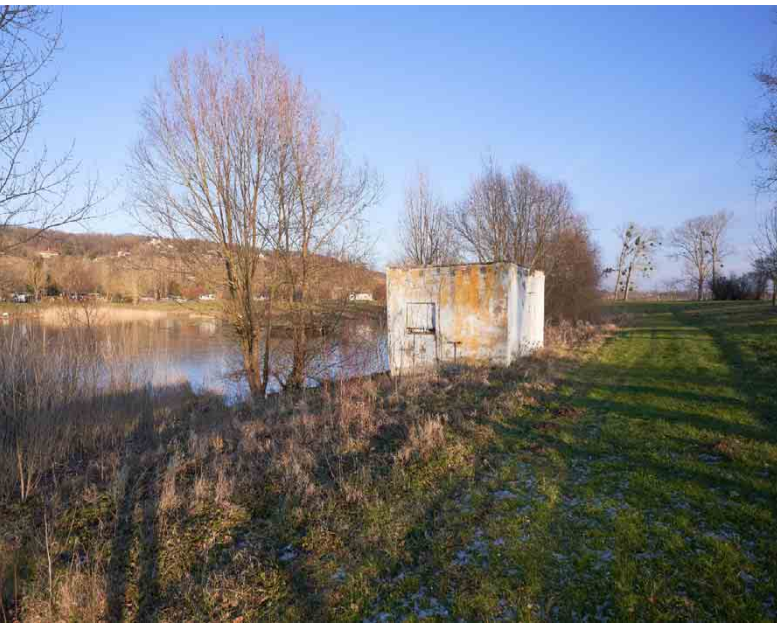
| Abb. 72 ehem. Badmeisterpavillon
