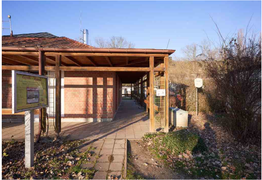
| Abb. 38 Überdachter Weg um das neue Sanitärgebäude
