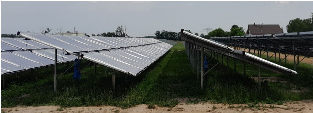
Abbildung 5-46: Aufständigung von Kollektor - Tischen mit Ramppfosten - Elementen
