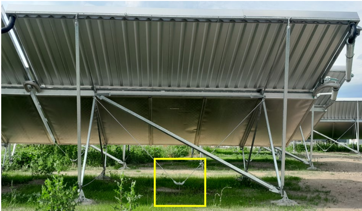
Abbildung 5-48: Befestigung eines Kollektortisch mit 26,6 m 2 Kollektorfläche der Solarthermie - Anlage in Wolmirstedt mit einem Erdanker
